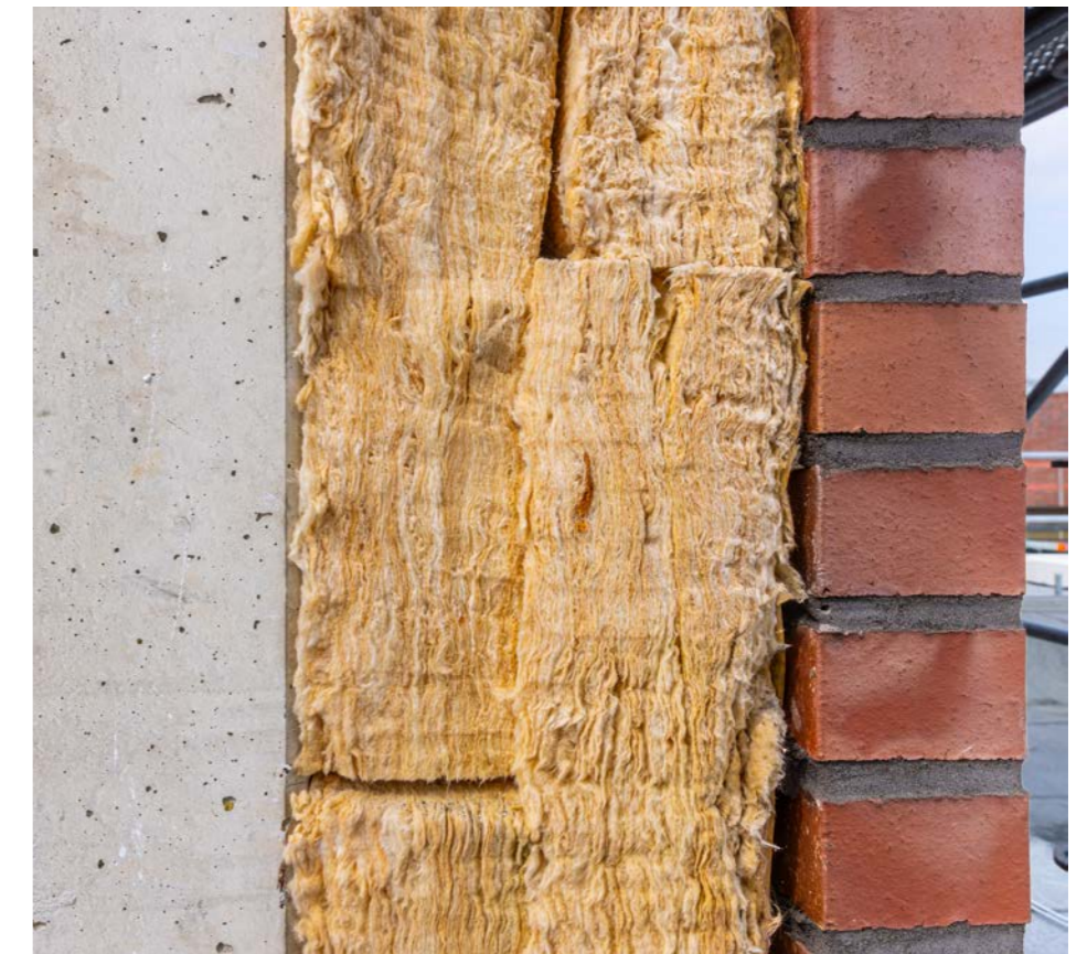
Hier ist deutlich sichtbar, dass die einzelnen Komponenten des Wandaufbaus bei einem Rückbau leicht und sortenrein voneinander trennbar sein werden.
